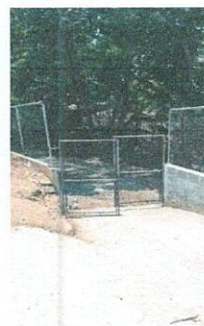
Foto 4: Sustitución de porton
