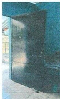
Foto 6: Sustitución de chapa del aula
