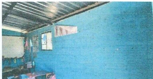
Foto 3: Fabricación e instalación de ventanas
