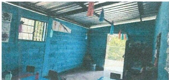
Foto1: Mejoramiento de estructura de aula tipo portico
