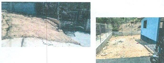
Foto 5: Mejoramiento de losa de patio y mejoramiento de cubierta de patio
